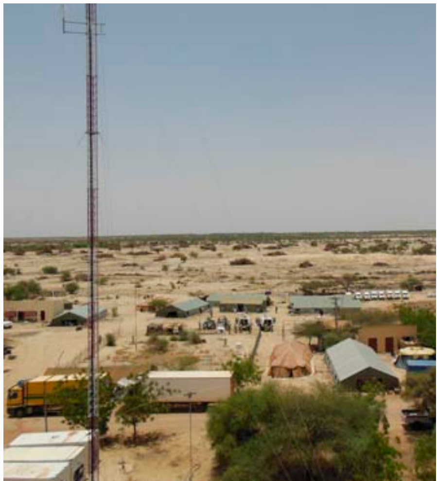
Campen i Mali. Soldater från Ing 2 bygger den del där svenska soldater ska bo från januari 2015. Foto: Försvarsmakten.
